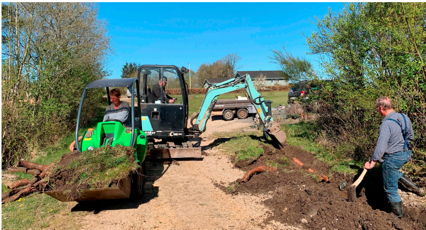
Det er dejligt at have udsigt til vandet - bare det altså ikke befinder sig i pøle og ælte på veje og i rabatter. Det kræver muskeltkraft, når problemet skal løses med en ny drænledning, men frivillige smøgede ærmerne op og kørte maskinerne i stilling. Og så blev vandproblemerne klaret her på Revlingebakken. I maskinerne er det Anette og Jørn Knudsen, med skovlen Preben Hald.
